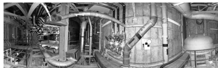
図1. ZFスキャナーにて計測したパノラマ画像データ(Intensity)
