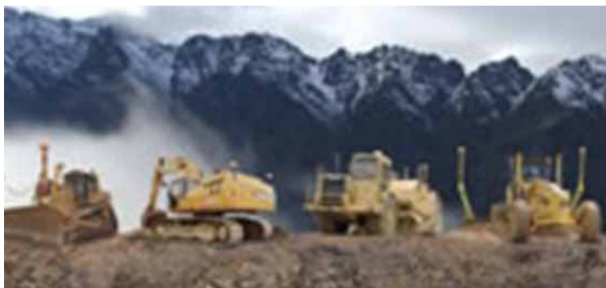
図7： 各種計測技術、ロボットなどによる造成工事短期化
