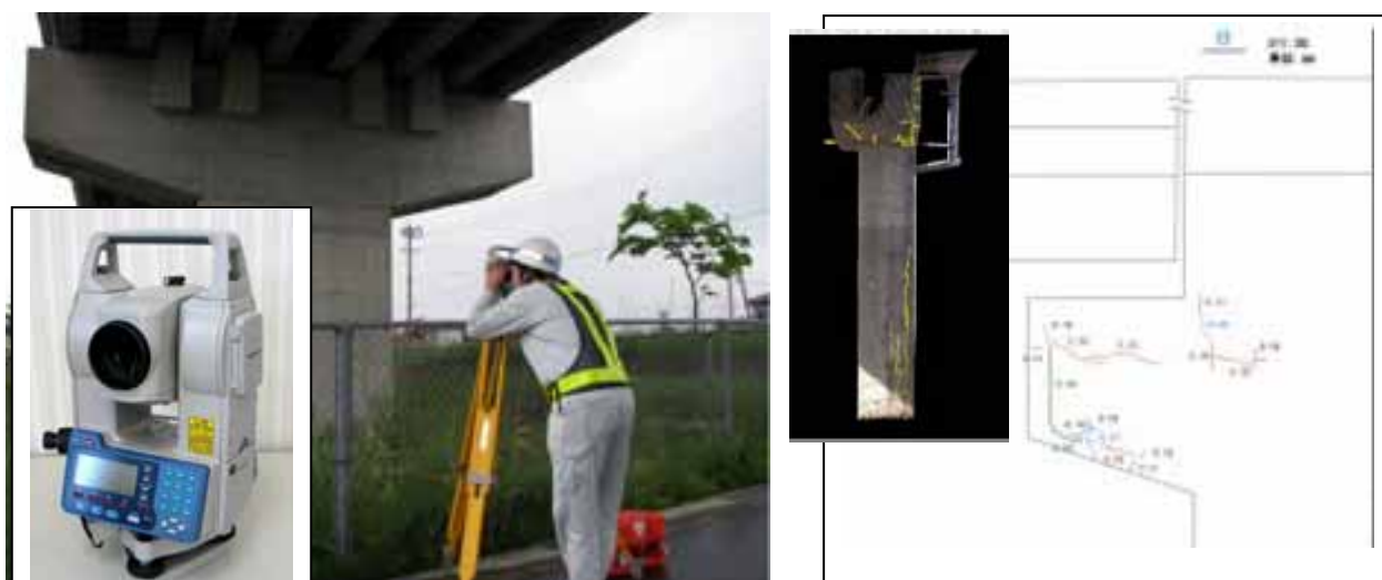
図 7 : コンクリート構造物の遠隔 3 次元クラックの計測
