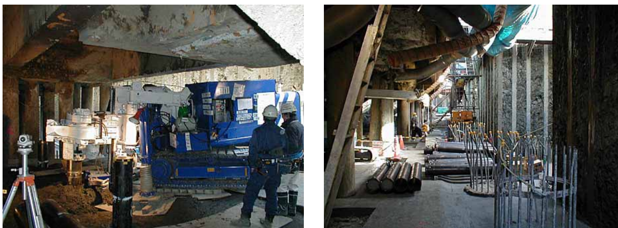
図 10：耐震工事現場の状況事例 出典：旭化成建材 EAZET 工法紹介 URL より
