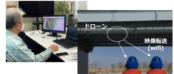
UAVによる橋梁のリモート点検システム
